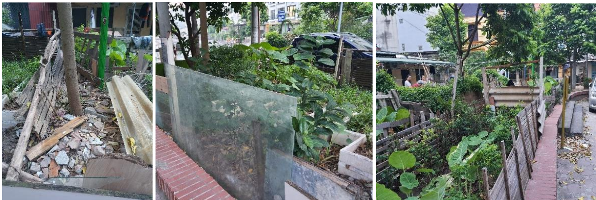
Figure 24 Dégradation constatée du jardin communautaire
