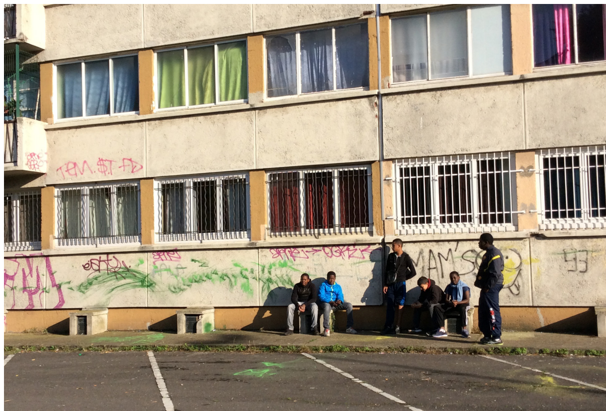
Figure 37 : Le parking à la Maladrerie
